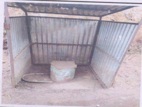
Foto 3: Sustitución de inodoro
