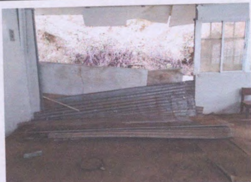
Foto 9: Reparación de aula con PVC
