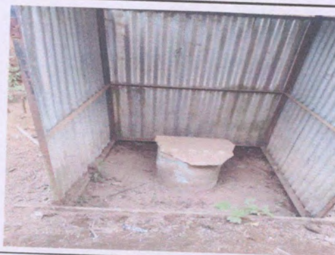
Foto 4: Sustitución de inodoro
