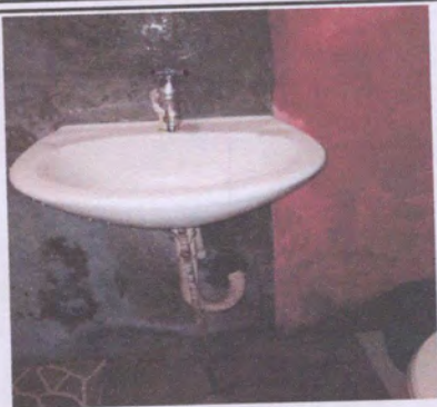
Foto 7: Sustitución de lavamanos
