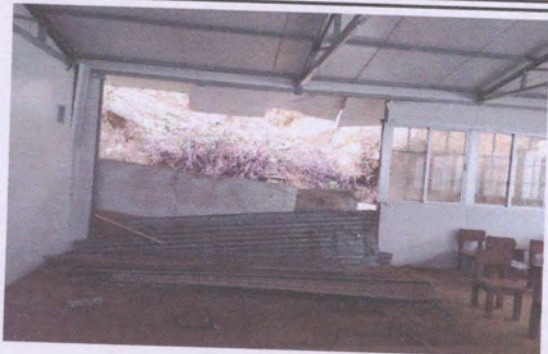
Foto1: Reparación de aula
