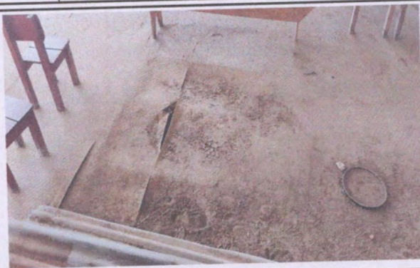
Foto 8: Sustitución de piso granito
